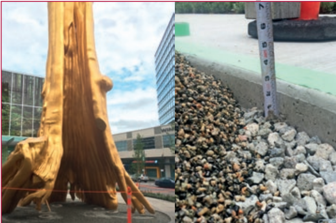
Absperren / abkleben / Schichtstärke 5 cm (2 inch) Block off / tape off / layer thickness 5 cm (2 inch)
